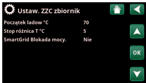
Menu: „Zaawansowany/Ustawienia/Zewnętrzne źródło ciepła”.
