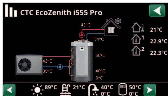
Strona menu głównego obszaru „Praca” z podłączoną pompą ciepła powietrze-woda CTC EcoAir. Gdy pompy pracują, wirują także widniejące na ekranie ikony pomp.
